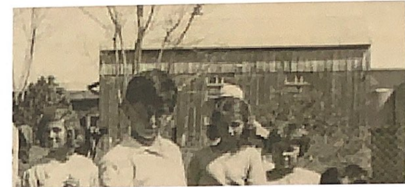
צריף בית הכנסת הניבט כאן בצילום משנת 1936, לא השתנה מאז, במהותו. קירותיו כיום מחופים טיח, יתכן ששלד העץ עדיין קיים ורק נשמע וחופה מבחוץ ומבפנים בחומרי חיפוי ובידוד. גג המבנה הוחלף לרעפים. | מקור: באדיבות משפחת שא נס
