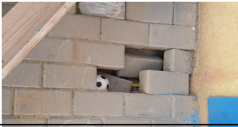
גן - ריצוף שקוע בחצר
